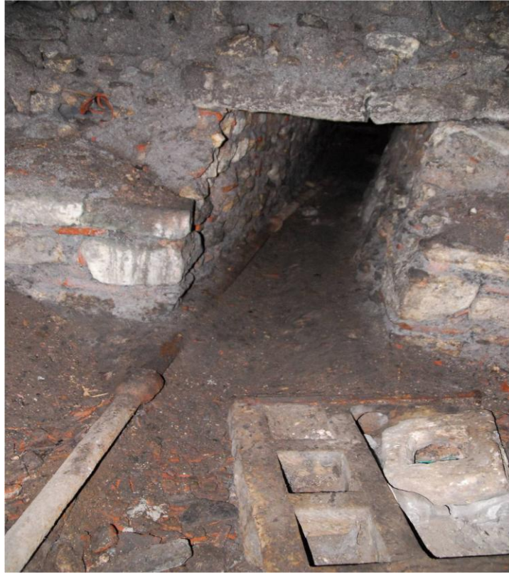
Fotoğraf 5 Sphendone içindeki Galerinin Girişi, Su dağıtım Sandığı, Künk ve Demir Boru (Fotoğraf Aygün Ö., Ç.)
